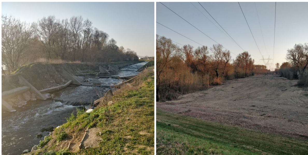
Slika 19. Kanal kojim se u Savu dovode pročišćene otpadne vode s CUPOVZ (lijevo); Trasa dalekovoda i prosjek u poplavnoj šumi u inundacijskom pojasu područja Save kod Hrušćice (desno) (foto: O. Škunca)
